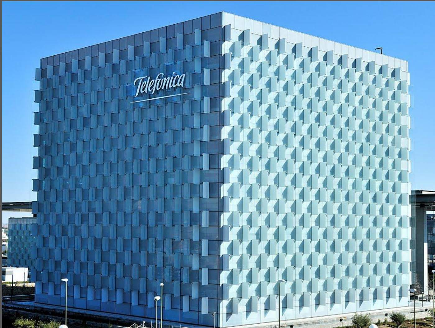
Edificio Telefónica en Madrid. Foto Kike Mad en Panoramio
